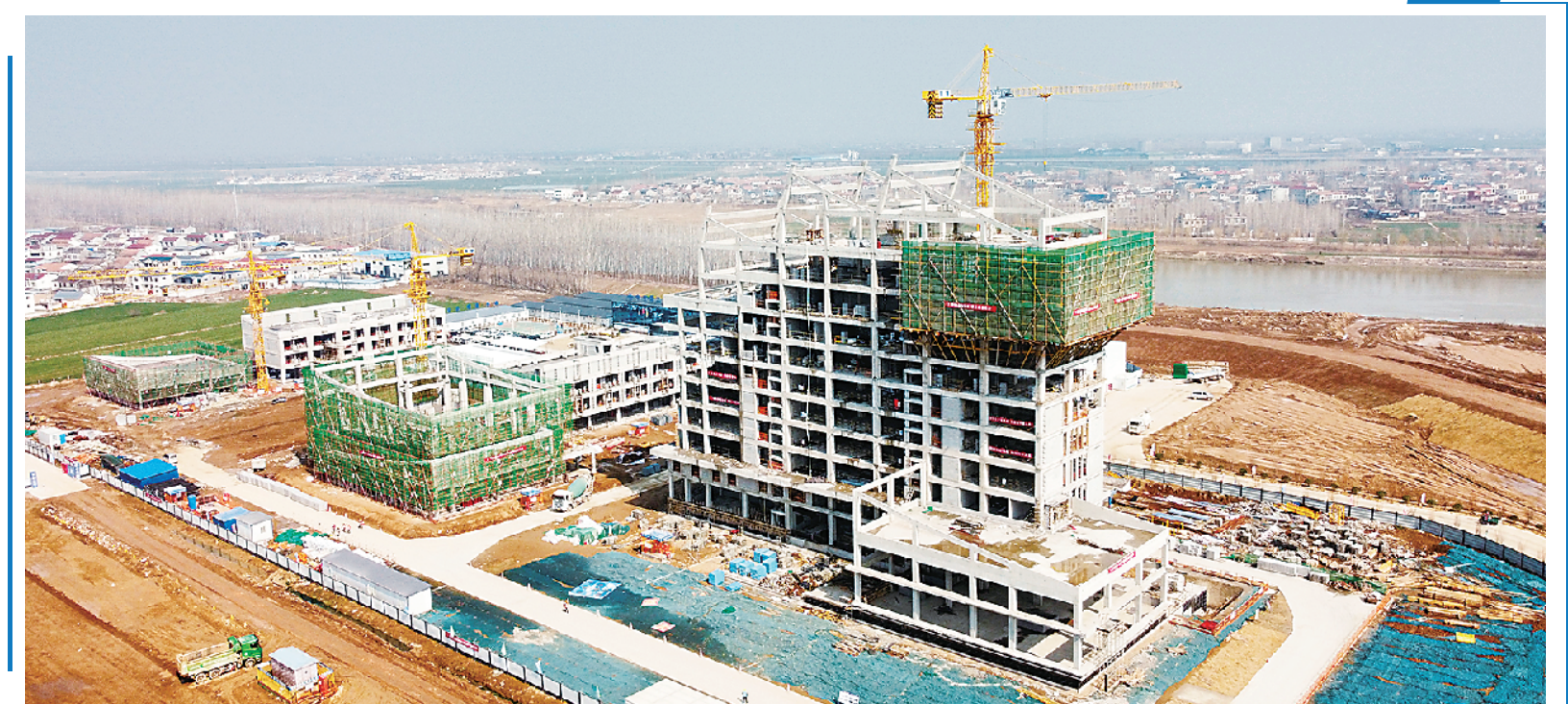
作为河南省内河航运“11246”工程的龙头项目,周口港小集作业区自2024年4月份开工建设以来,在省、市各部门的通力合作下进展顺利。图为周口港小集作业区施工现场。
